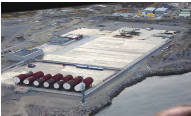
Р и с. 1. Долговременное хранение реакторных отсеков на береговой площадке пункта долговременного хранения «Сайда»
