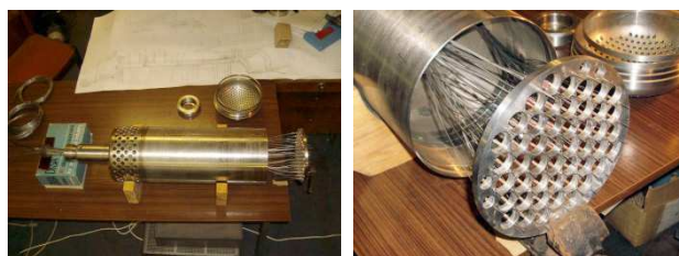
Р и с. 4. Монтаж измерительной решетки с термопарами и зондами давления в шахте модели напорного тракта ВВЭР-1000
