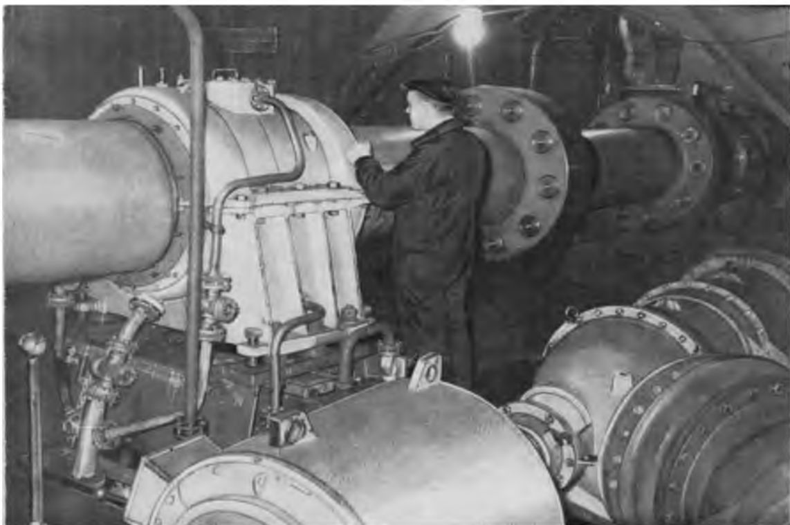
† Рис. 3. Средняя линия вала и кормовой дифференциальный насос.
