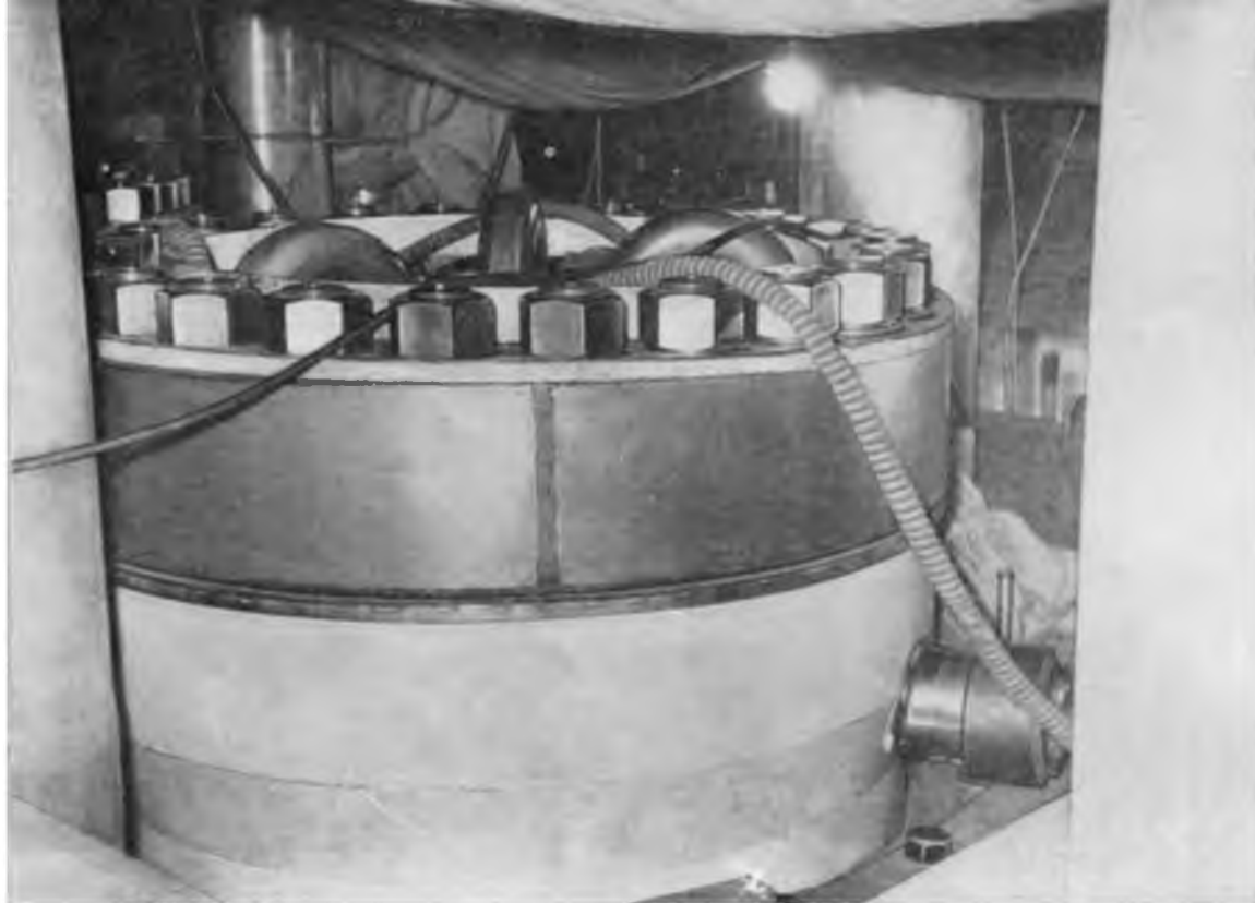
† Рис. 17. Верх смонтированного реактора.
