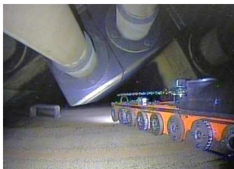
Р и с. 6. Робототехнический комплекс РТК-74 для восстановления зазора графитовая кладка—металлоконструкции схемы «КЖ» внутри реакторного пространства
