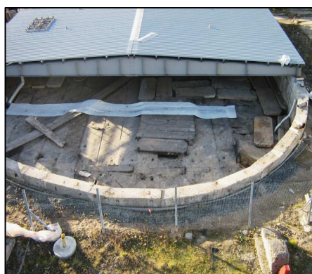
Р и с. 5. Вид на плитное перекрытие емкости хранения после снятия половины крыши с северной стороны БСХ-3А
