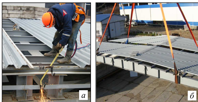
Р и с. 4. Операции демонтажа крыши БСХ-3А: а — разделение конструкции на две части; б — перемещение одной из частей краном КПМ-40
